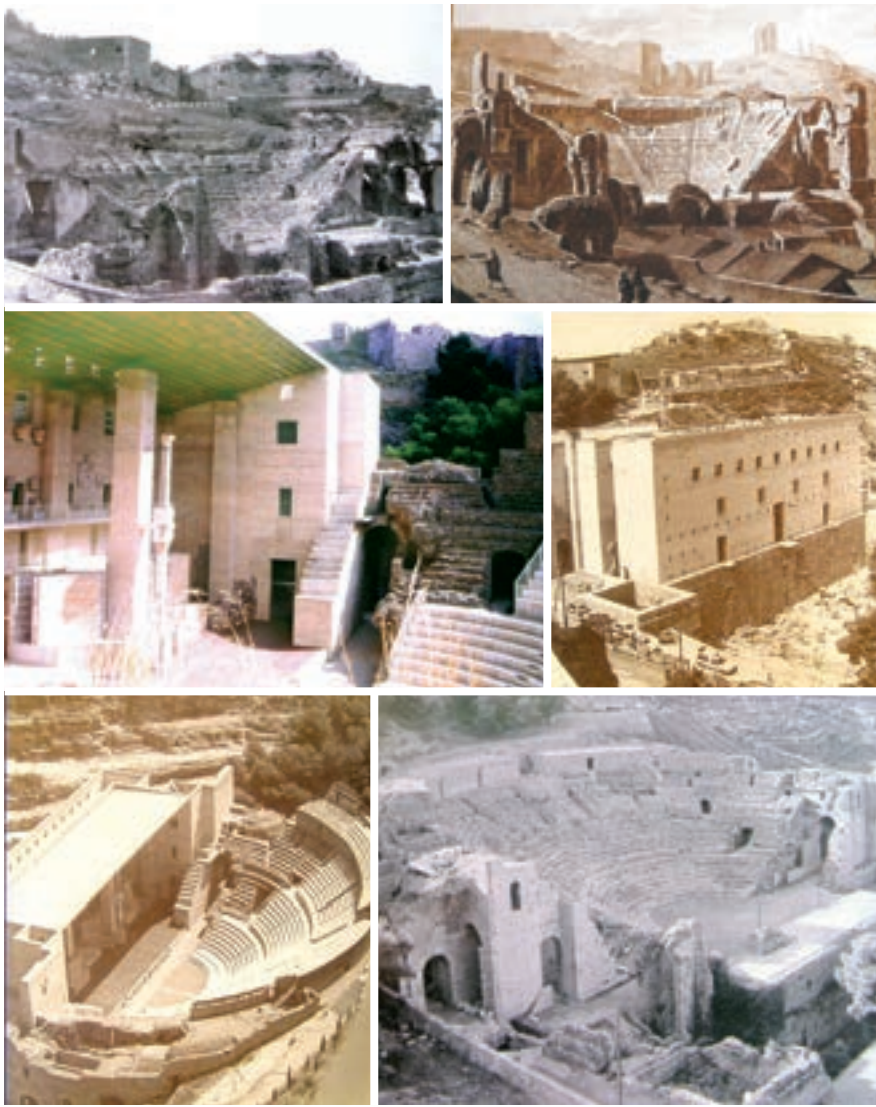
Vistas anteriores y posteriores del teatro romano de Sagunto tras las obras proyectadas por Grassi y Portacelli. Restituirlo a su estado "original" como propugna una sentencia original, supone un desatino de calibre mayor que el realizado por los autores como ejercicio académico, incluso en la hipótesis que fuese posible hacerse.
