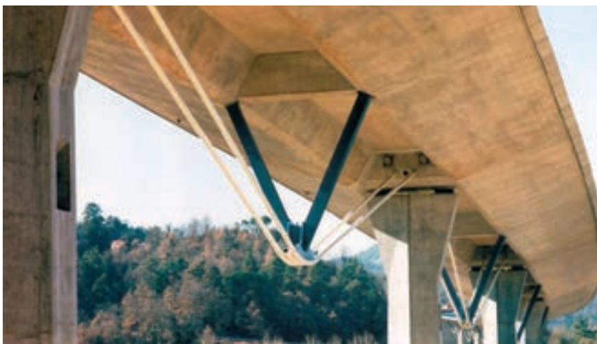
Viaducto d'Osormort. Eix transversal. J. Manterola
