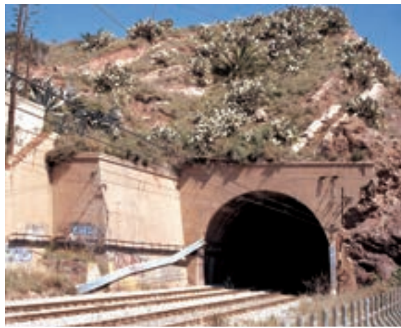
Boca sur. Túnel de Mongat, modificada.
