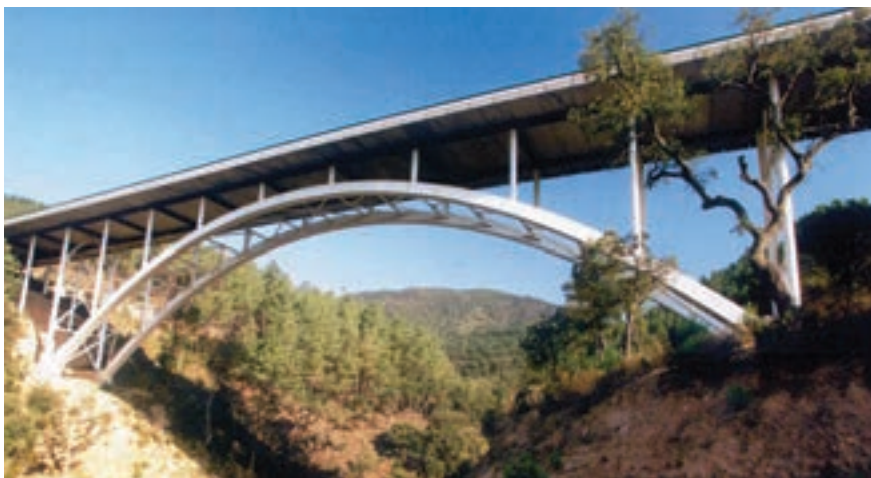
Viaducto de les Fosses. Eix transversal. M. Reventos
