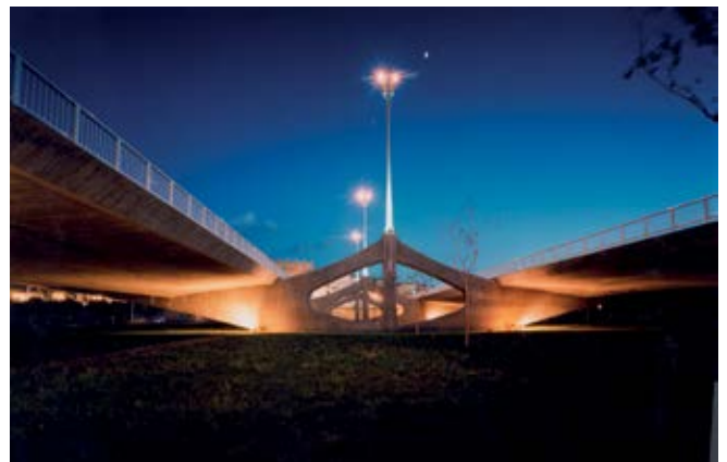
LA PILA CON LOS DOS TABLEROS
