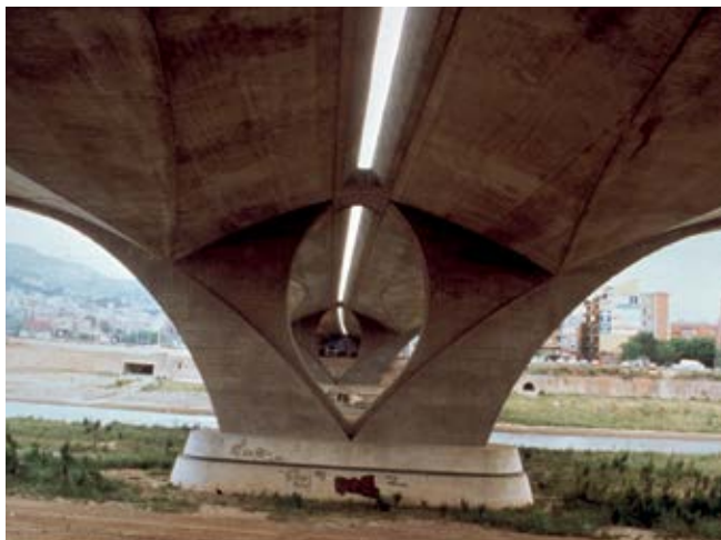
LA PILA Y LOS DOS TABLEROS
