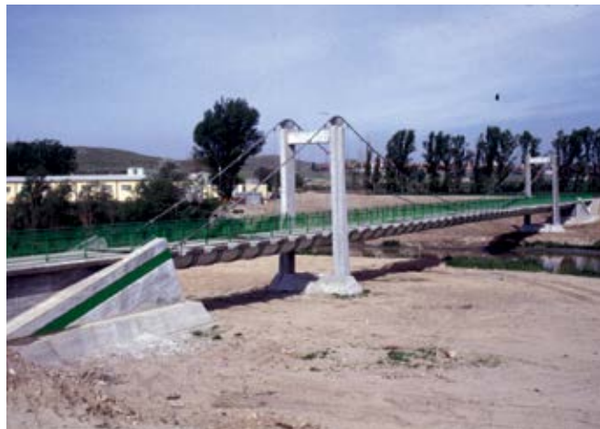
Puente para el paso de un colector y vehículos ligeros sobre el río Jarama. 65 m de luz. 1988
