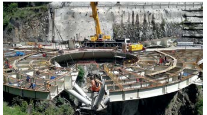
LA ROTONDA EN CONSTRUCCIÓN
