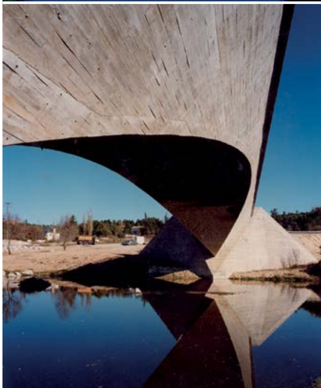
Puente de Torrelodones sobre el río Guadarrama. 56 m de luz. 1988
