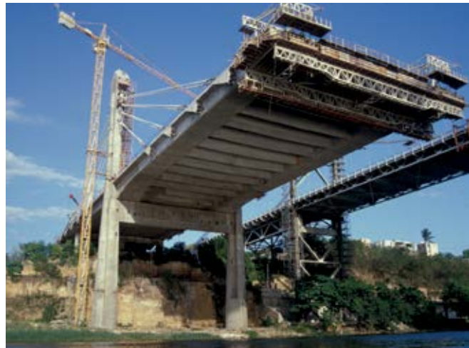
EL PUENTE EN CONSTRUCCIÓN
