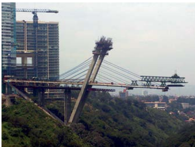
EL PUENTE EN CONSTRUCCIÓN
