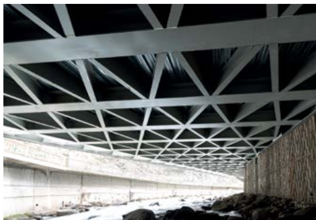
EL TABLERO TRIANGULADO EN PLANTA
