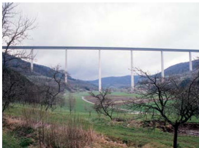
Viaducto de Kochertal cerca de Geislingen en Alemania. Vanos de 138 m de luz. Altura de pilas 180 m. 1980
