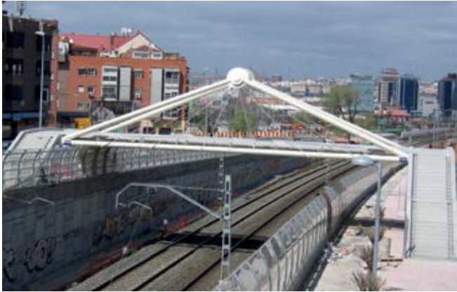
Pasarelas de Entrevías. Madrid. 20,5 m de luz. 2007
