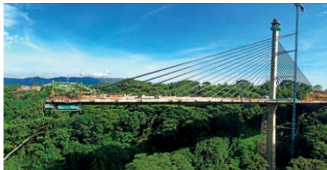
EL PUENTE EN CONSTRUCCIÓN
