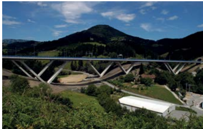
LOS DOS VIADUCTOS
