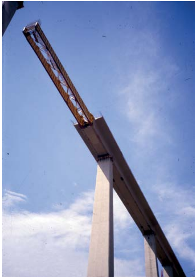
ATENQUIQUE 1 EN CONSTRUCCIÓN
