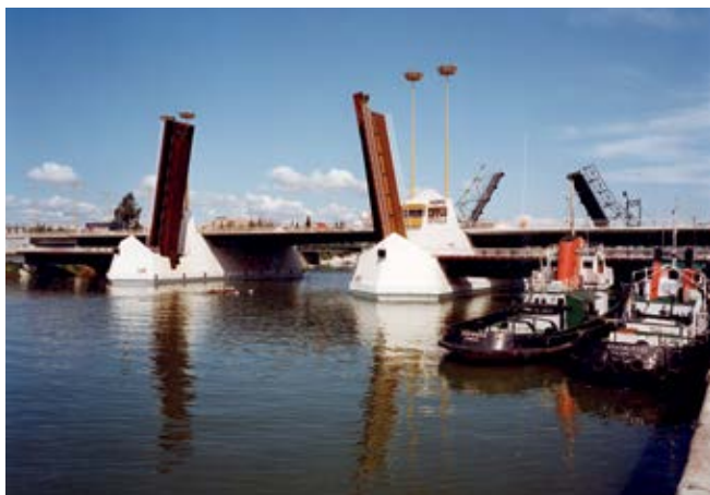
Puente de las Delicias sobre la dársena del Guadalquivir en Sevilla. 42 m de luz. 1991. El puente de ferrocarril abierto y el de carretera cerrado
