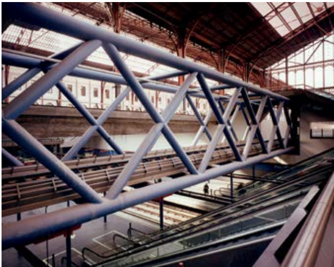
Puente de ferrocarril sobre la estación de Príncipe Pío. 38,5 m de luz. 1994
