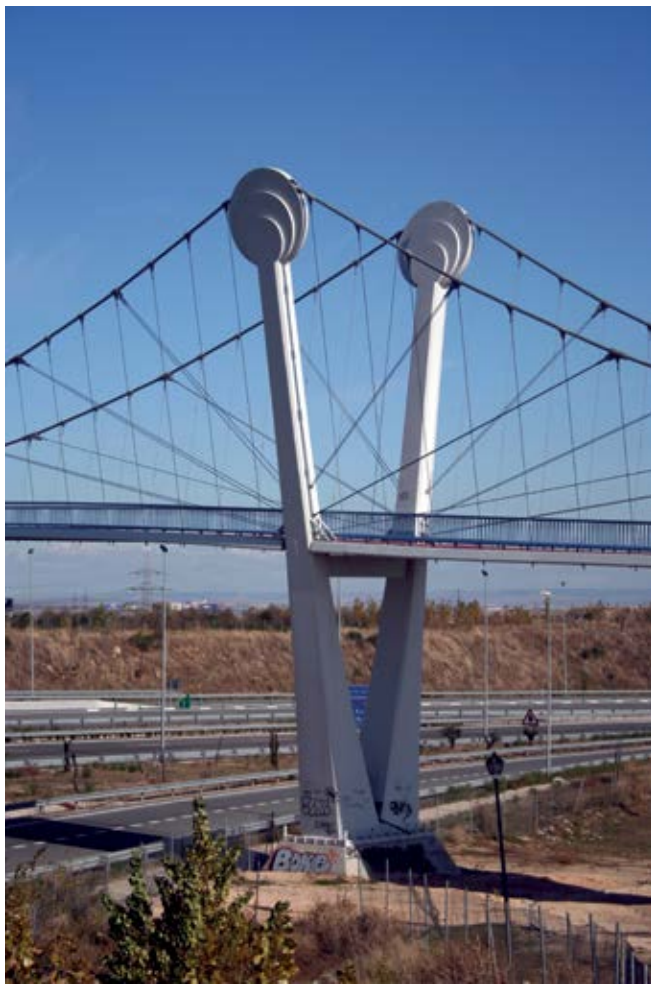
Torre de la pasarela sobre la R-3 en Madrid. 110 m de luz. 2008
