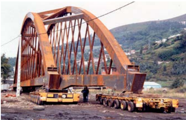
TRASLADO DEL ARCO SOBRE CARRETONES
