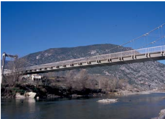
Puente de Figols sobre el río Segre. Lérida. 80 m de luz. 1984
