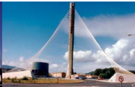
EL PUENTE TERMINADO
