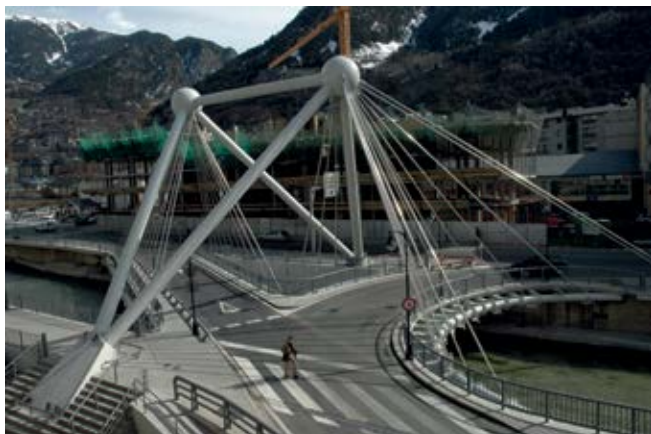
LOS DOS RAMALES DEL PUENTE
