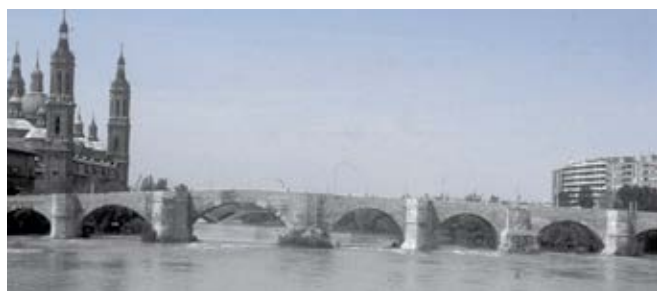
EL PUENTE EN LA ACTUALIDAD
