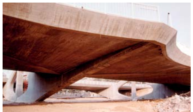
VOLADIZO DE LA PILA CON EL TABLERO
