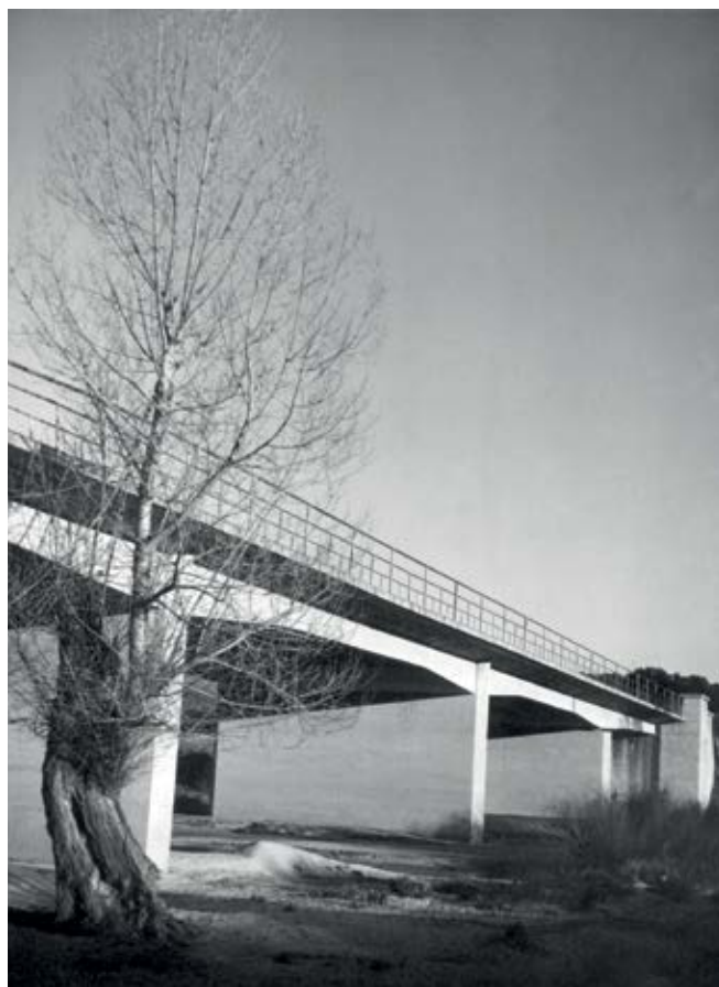
Colección de puentes de Altura Estricta. C. Fernández Casado: Puente del Pardo sobre el río Manzanares. 20 m de luz. 1935
