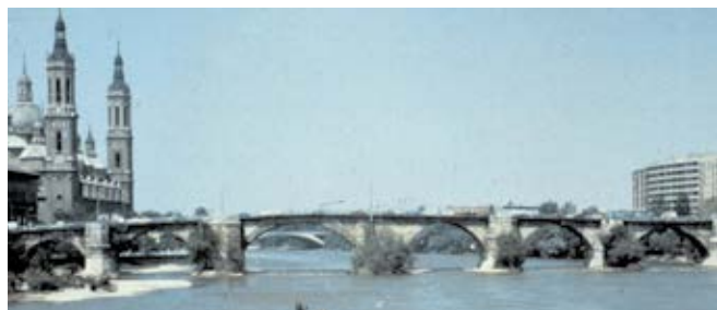
EL PUENTE ANTES DE LA REHABILITACIÓN
