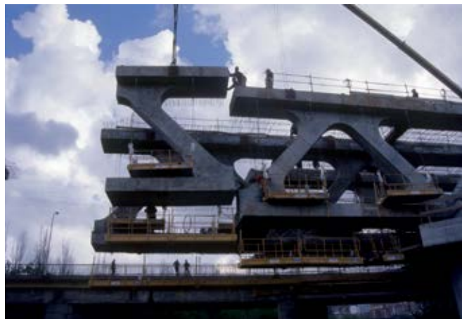
MONTAJE DE UNA DOVELA
