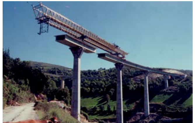
MONTAJE DE DOVELAS
