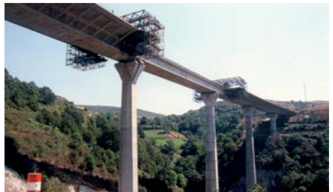
CONSTRUCCIÓN DE LOS VOLADIZOS LATERALES
