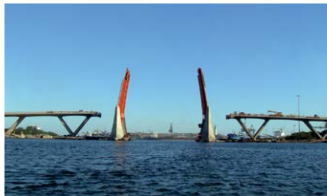
EL PUENTE ABIERTO
