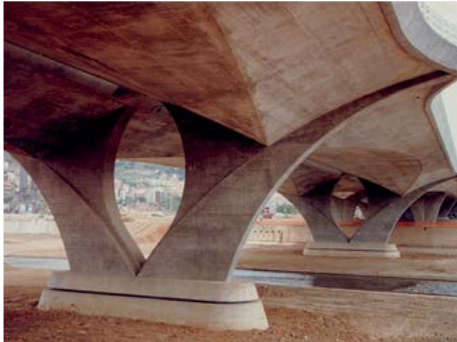
VISTA GENERAL DEL PUENTE
