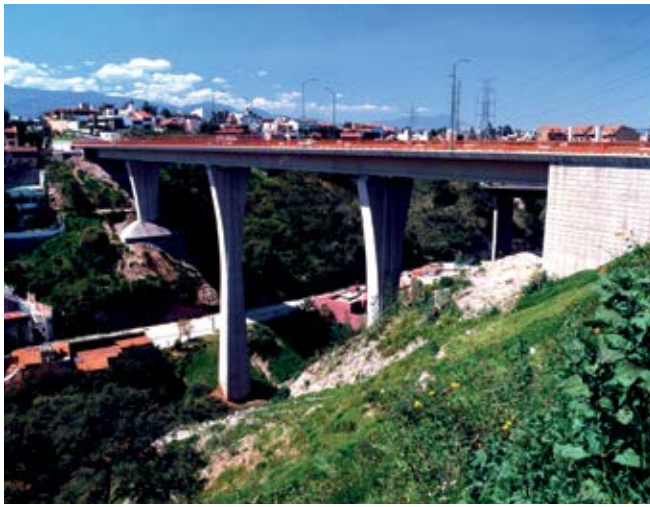
Viaducto de Huixquilucan en la ciudad de México. 50 m de luz. 1994
