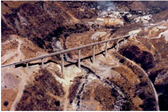
Viaducto Atenquique 1 sobre el río Tuxpan. 60 m de luz. México. 1990
