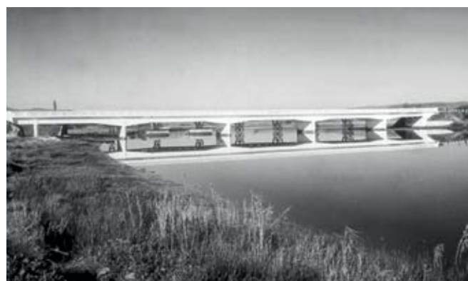
Colección de puentes de Altura Estricta. C. Fernández Casado: Puente de Palmones sobre este río cerca de Algecitas. 30 m de luz. 1954.
