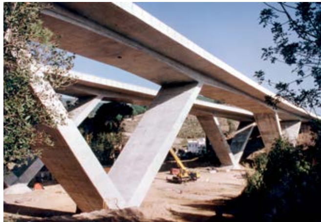
Puentes sobre la Riera de L'Ubo cerca de Barcelona. 80 m de luz. 1994
