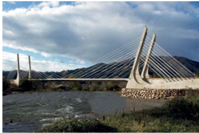
Puente sobre el río Besaya en Cantabria. 135 m de luz. 2009
