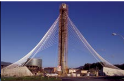
EL PUENTE EN CONSTRUCCIÓN
