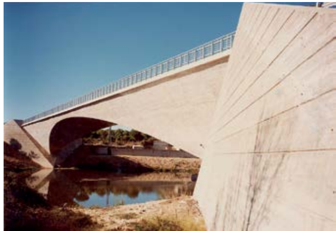
Puente de Torreldones sobre el río Guadarrama. 56 m de luz. 1988
