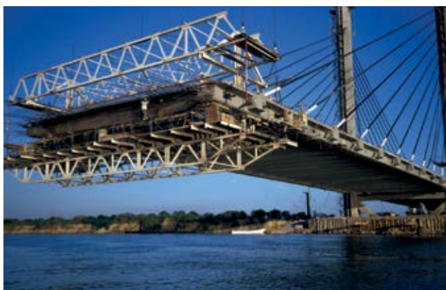
EL PUENTE EN CONSTRUCCIÓN
