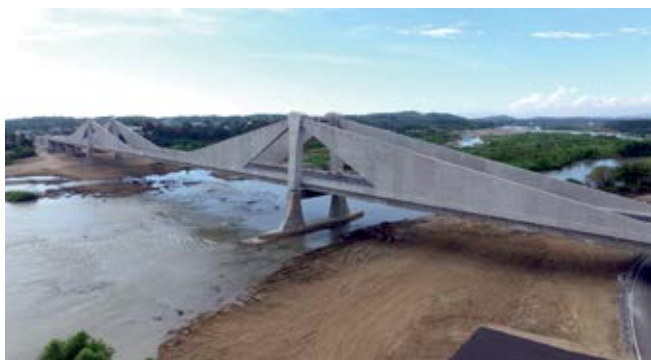
EL PUENTE EN CONSTRUCCIÓN
