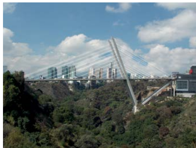
Puente de Vidalta sobre una barranca en la ciudad de México. 180 m de luz. 2013.
