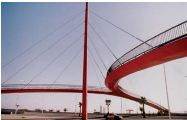
LA PASARELA EN SU NUEVA SITUACIÓN SOBRE EL CINTURÓN LITORAL
