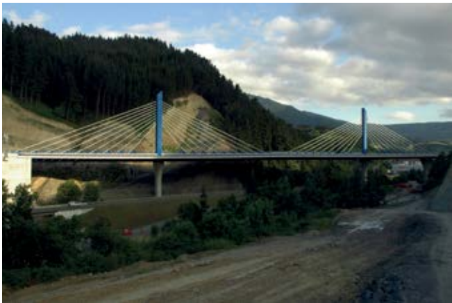
EL TRAMO ATIRANTADO
