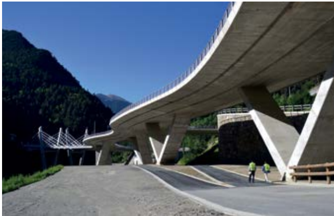
RAMAL, ROTONDA Y PUENTE
