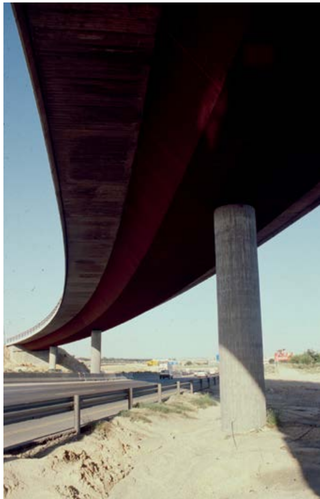
Paso superior sobre la M-40. Estructura mixta. 1994
