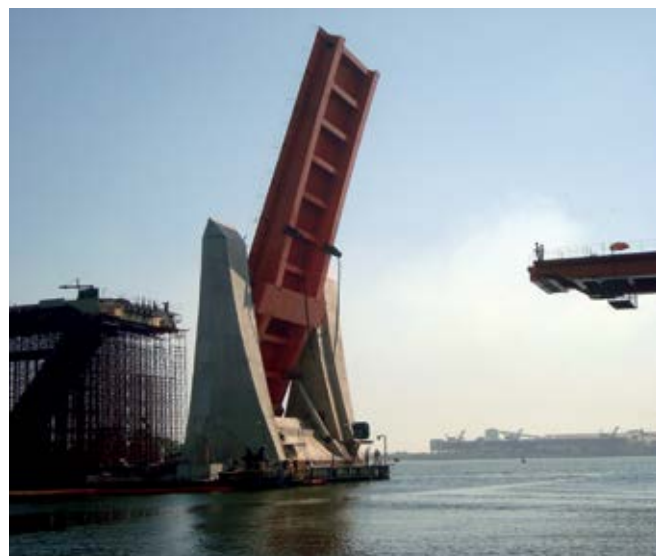
UNA HOJA DEL TRAMO BASCULANTE
