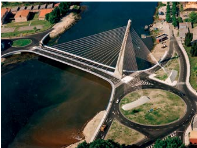
LA PILA CON LOS DOS TABLEROS
