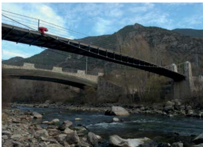
Pasarela de Arcalís sobre la Noguera Pallaresa. Lérida. 2009
