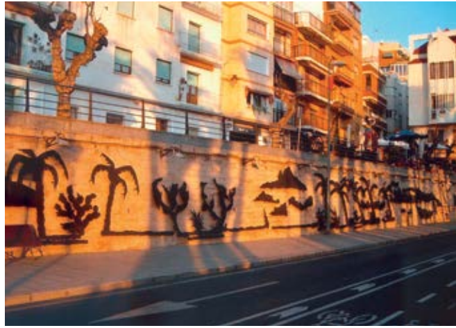
Benidorm (Valencia) – La recuperación de un muro
