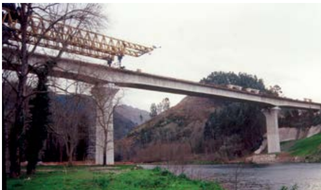
Viaducto de Ribadesella sobre el río Sella. Asturias. 100 m de luz. 2002
