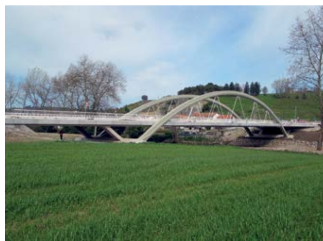
EL ARCO Y LOS JABALCONES POSTERIORES
