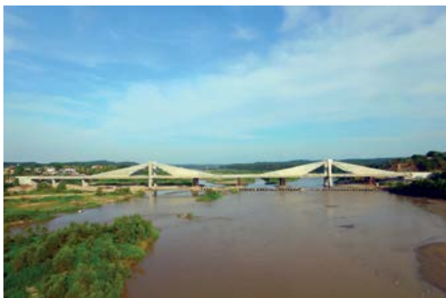
VISTA DE LOS DOS PUENTES
