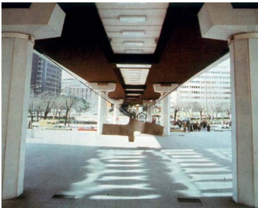
Madrid. Viaducto de Juan Bravo
