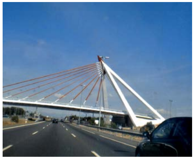
Madrid: Puente en autovía de los Coruña. El color define los elementos estructurales
