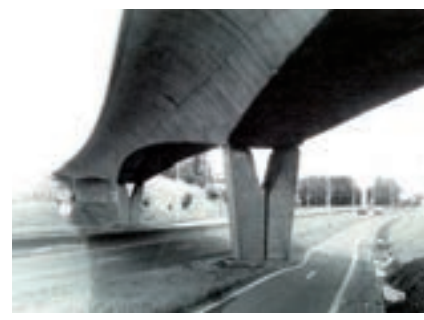
Fig. 7. Puente de Orly. Freyssinet.
