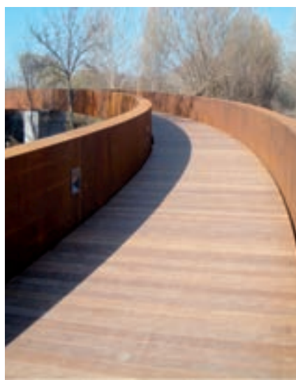
Pasarela de San Jorge.
