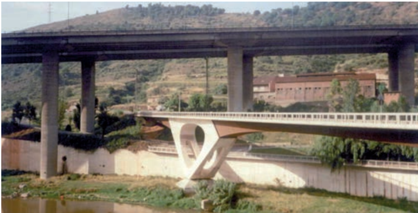
Dos soluciones para la misma función, en el Llobregat; el inferior de Fernández Ordóñez.
