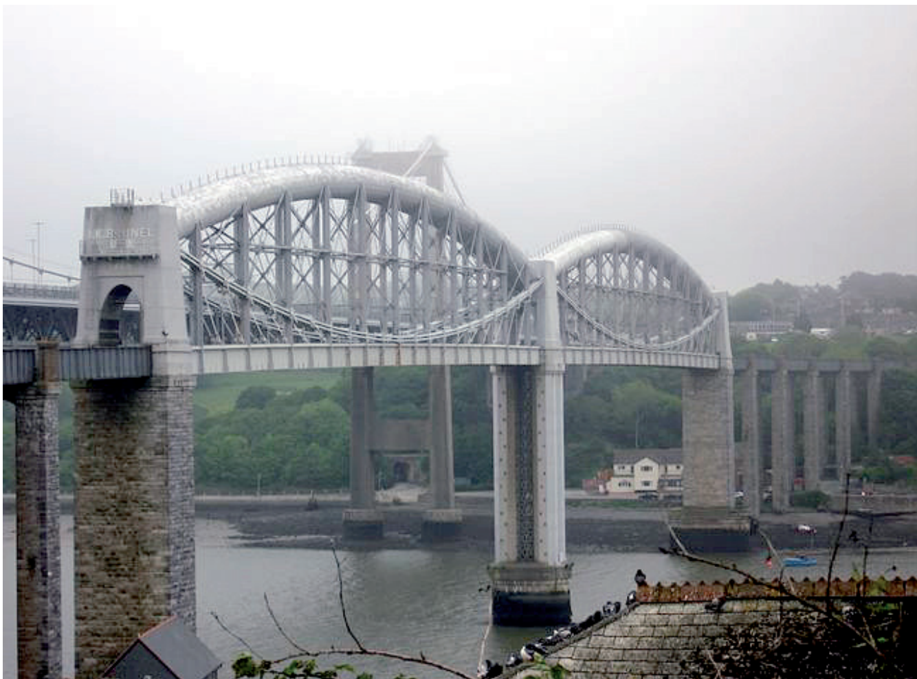
Imágen del puente de Saltash.
