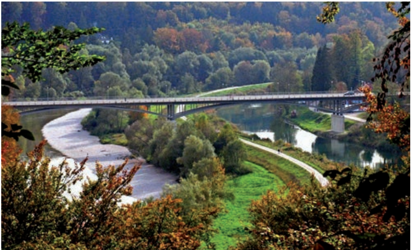
15e - Las estructuras metálicas en arco rebajado y los modernos puentes en celosía con tablero superior de gran luz son tipos que proporcionan siempre transparencia.
