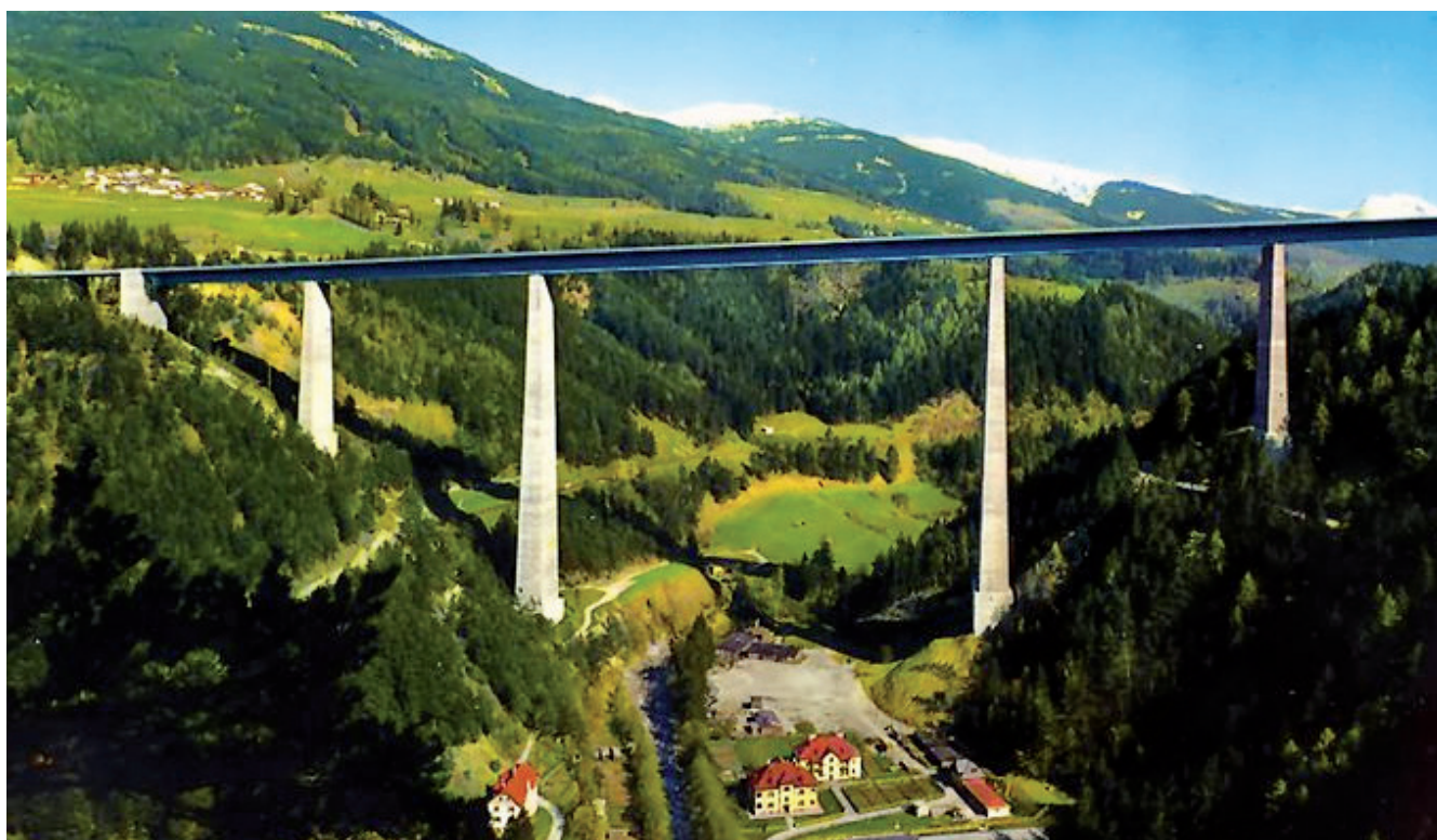
16d - Puente de Europa, Autovía del Brennero. El valle alpino está formidablemente enmarcado por la espléndida "ouvrage d'art". Luz central del dintel 192m y pilas de 143m de altura. Relación L / H = 1.34 . No es la relación áurea, pero el resultado es brillante.
