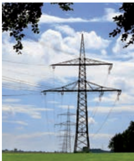
3 - Torre de alta tensión.
