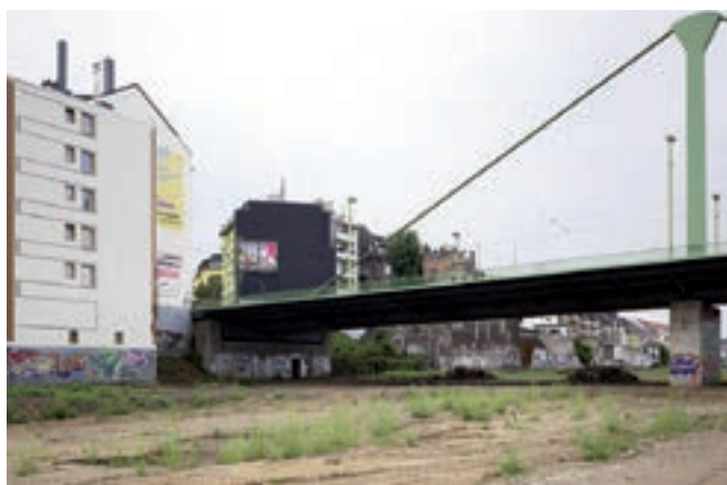
10 - El puente hubiera resultado bien en otro sitio, no precisamente en éste.
