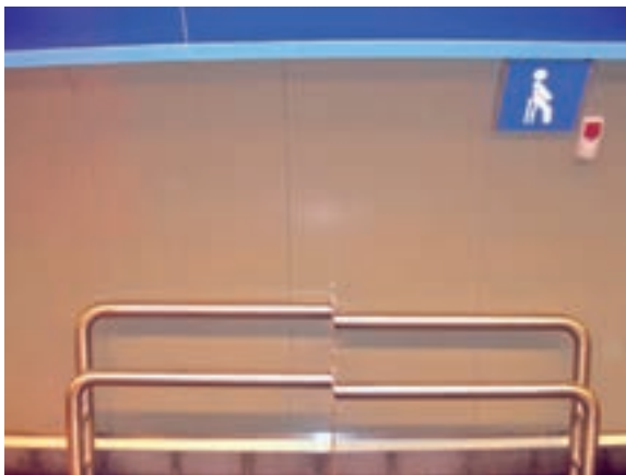
Metro Madrid. Asiento (?) precisa señalización al no apreciarse sus funciones.
