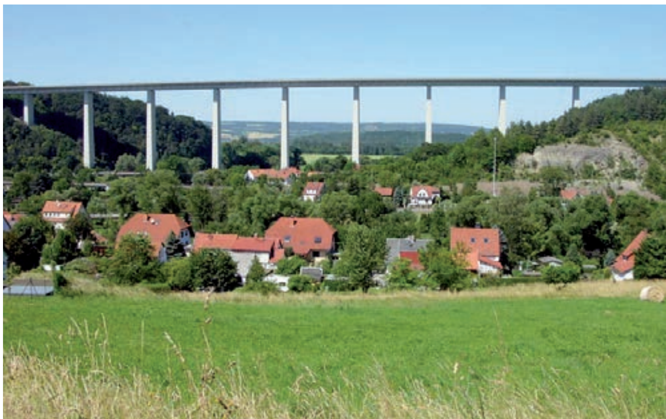
16e - Otro viaducto alemán para autopista con doble tablero y una única pila por apoyo. En este caso, las luces son más pequeñas que la altura de pilas, pero el alzado es agradable.
