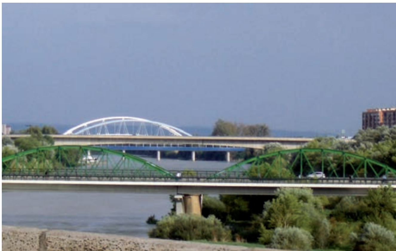
14 - Puentes sobre el Ebro en Zaragoza. Un conjunto de objetos bellos no crea sistemáticamente un paisaje hermoso.
