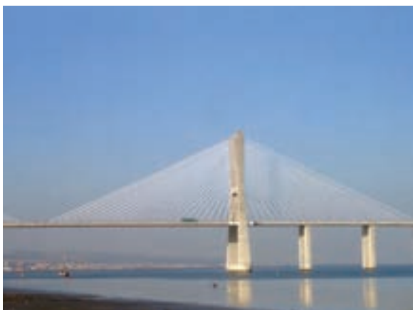
Puente Vasco de Gama (Lisboa). Pilas secundarias, ¿contextualizadas con la principal?
