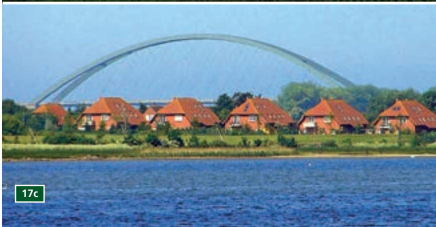
17a/b/c - Puente de Fermansund.
