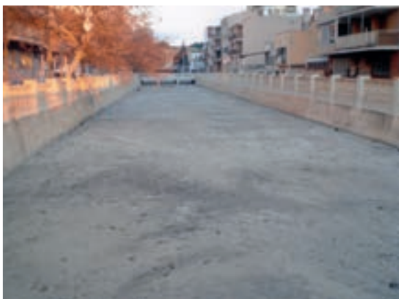
Almuñecar (Granada). Canalización en el casco urbano, hormigón.
