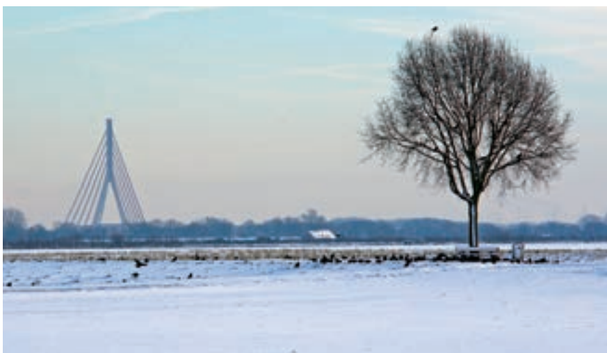
17f - Torre del puente de la Flehe, Alemania.
