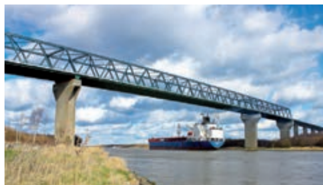
11 - Problema de cruce resuelto con tablas de doble entrada y manual: luz pequeña, solución x; luz grande, solución y. No existe diseño alguno y la transición entre tipos estructurales es un mero contacto.
