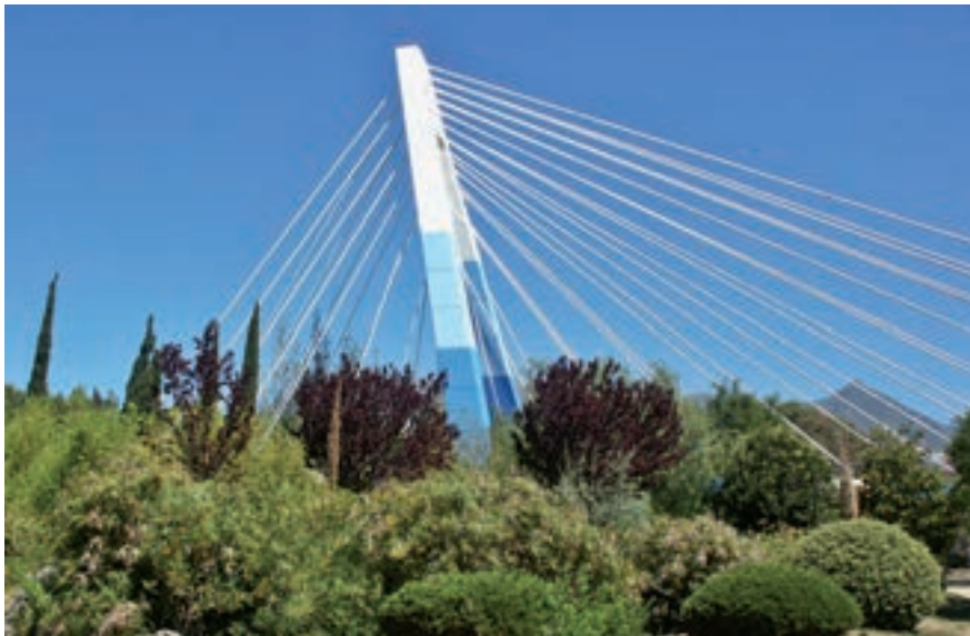
17e - Torre de puente de tirantes.
