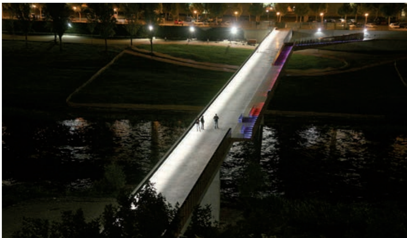
Pasarela sobre el río Segre en Lleida con suelo de fibra de vidrio translúcida e iluminación integrada bajo el suelo.
