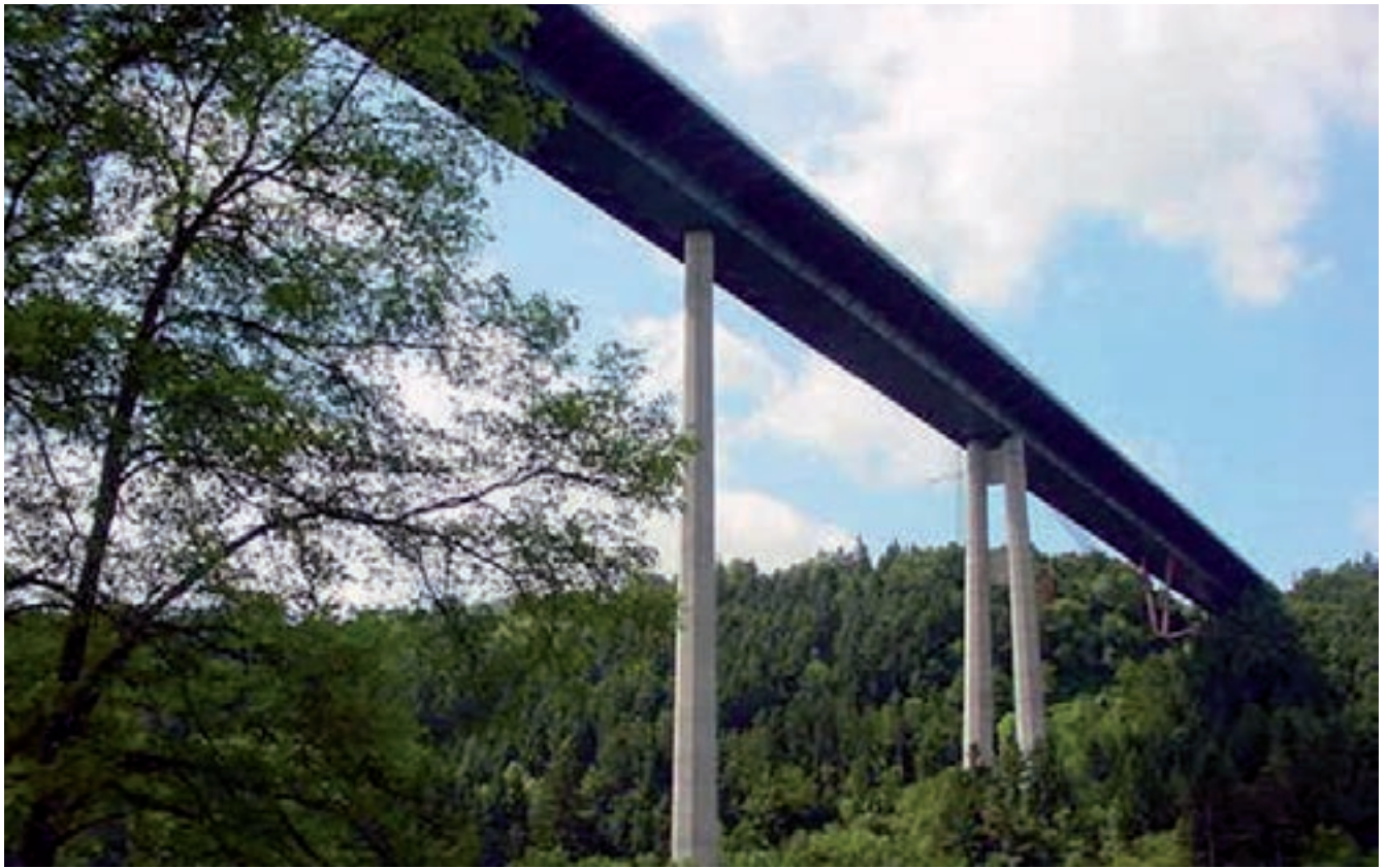
15d - Ejemplo de respeto al valle con la ubicación de las pilas estrictas en los lugares adecuados aunque den lugar a una gran luz es el viaducto de Kochertall.
