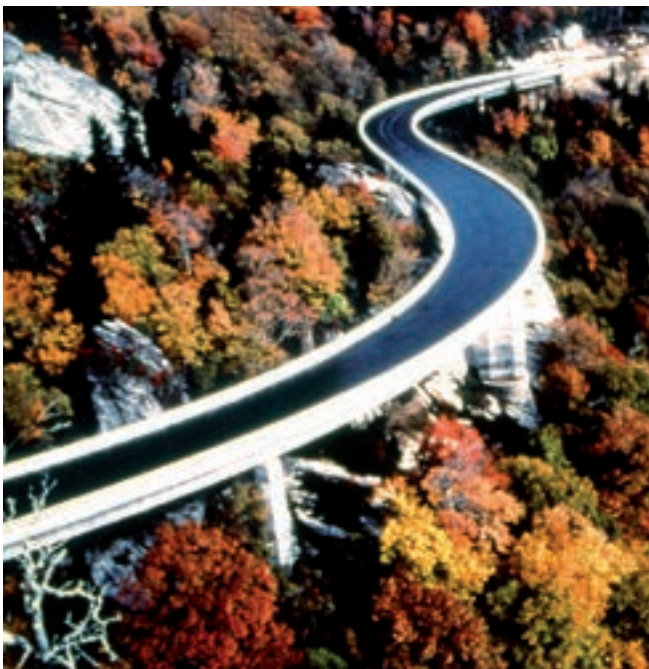
16b - Viaducto de Linn Cove en la carretera de acceso a un Prque Nacional de EEUU. La estructura cruza un bosque de árboles de hojas caducas, bosque de propiedad privada y cuyo propietario rechazó la indemnización económica y sólo puso como condición que no se talara un solo árbol durante su construcción. Todo el viaducto, - cimentaciones, pilas y tablero, se construyó desde arriba y no se taló árbol alguno como exigió el dueño del bosque.
