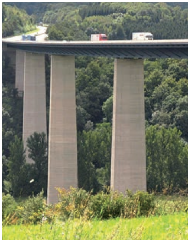
16c - Viaducto alemán para doble calzada de autopista, con tablero único y una sola pila por apoyo. Transparencia y encaje geométrico adecuado.
