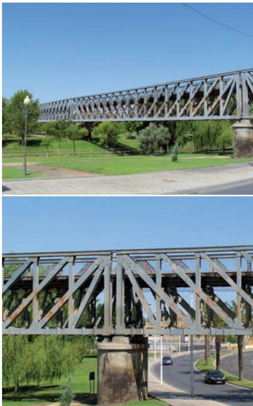
Puente del Ferrocarril.
