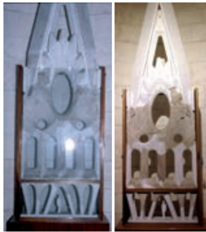
Imagen 17. Ventanal nave central.
