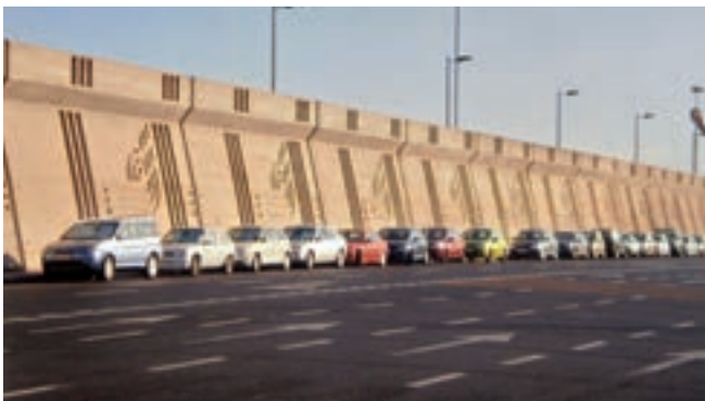
La Gomera, Canarias. El espaldón del puerto, un gran muro bien aprovechado.
