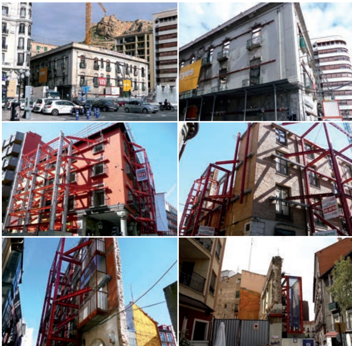
Fig. 6. Dos vistas de lo único que fue conservado del Hotel Palas de Alicante, antes de sustituir sus enlucidos de acabado final en sus fachadas; y otras actuaciones llevadas a cabo con idéntica filosofía, dado que la misma goza del beneplácito de los que no tienen que financiarla con su dinero, en cualquier ciudad española, como por ejemplo reflejan estas casas de Valladolid.
