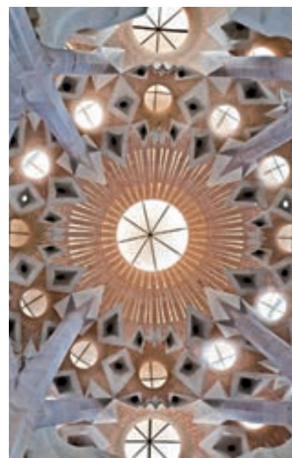
Imagen 18. Bóvedas del crucero.
