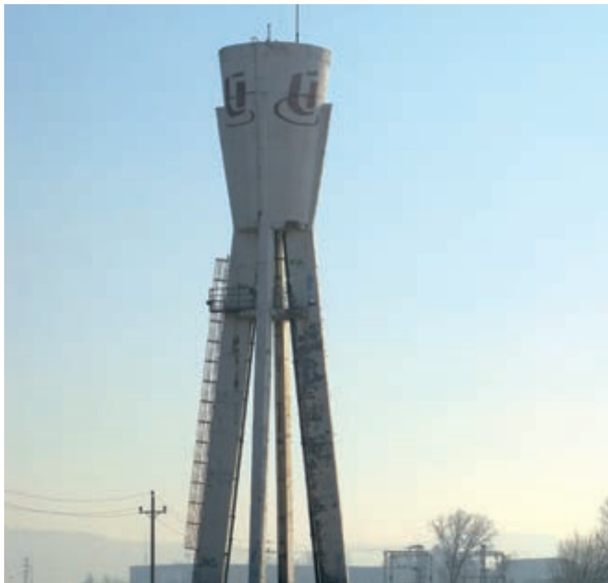
Figura 5. Depósito de agua en el Polígono Industrial de San Cristobal, en Valladolid.
