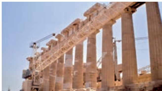
Atenas, obras en el Partenon. El color como elemento de camuflaje de las maquinarias.
