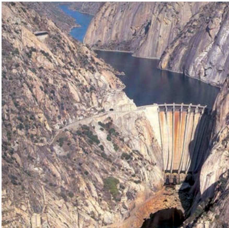
Figura 6. Presa de Aldeadávila.
