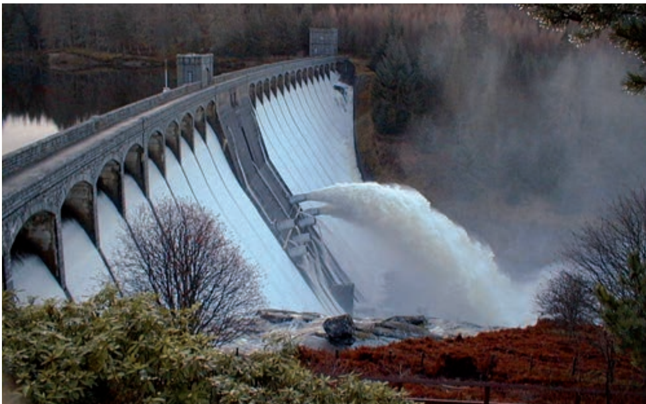
Figura 2. Presa de Virnwy.
