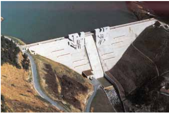
Figura 17. Presa de Arriarán.
