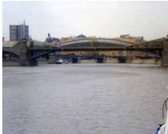
Fig.2. Puente en Moscú a 200 m de la fig.1.
