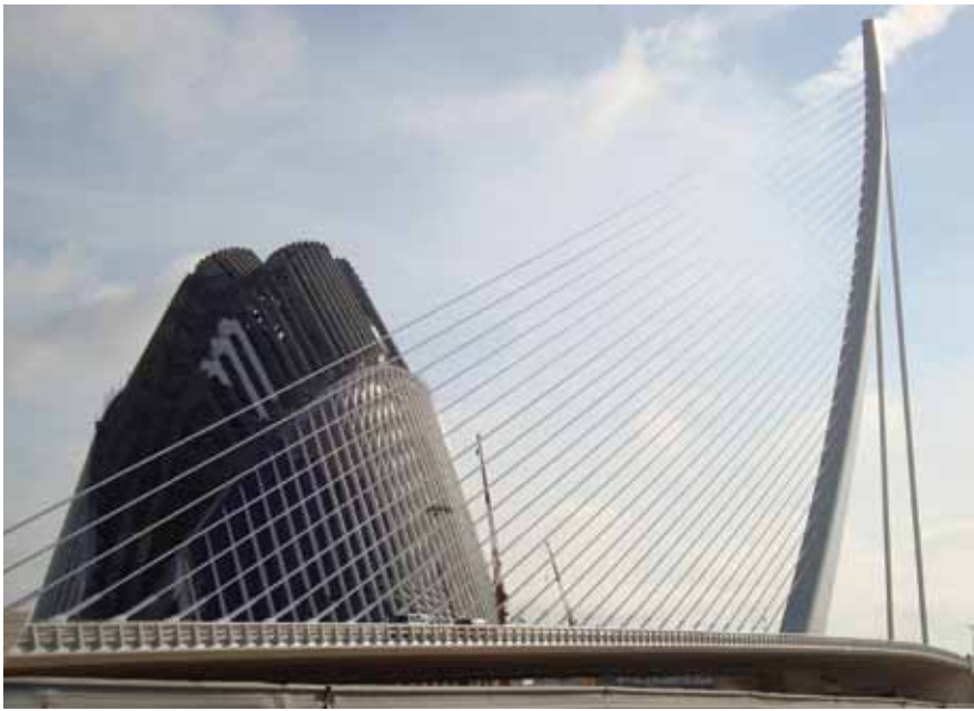
Figura 10. Puente del Assut d'Or, de Calatrava. Foto V. Yepes.
