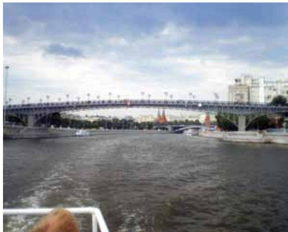
Fig.1. Puente en Moscú a 200 m de la fig.2.
