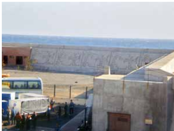
Fig.5. Espaldón en el puerto de la Gomera. Un buen encofrado.
