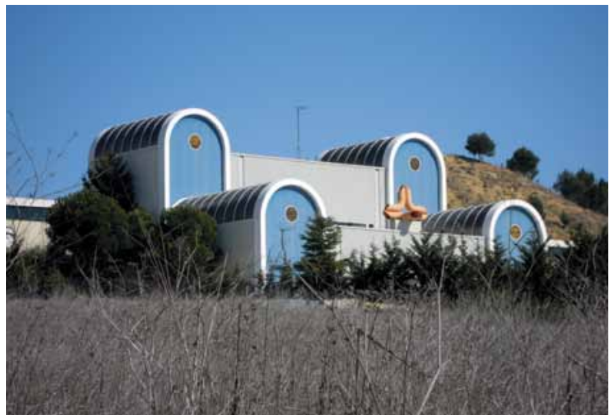
Figura 20. Depósito de agua en zona urbana. Depósito de Las Contiendas (Valladolid)
