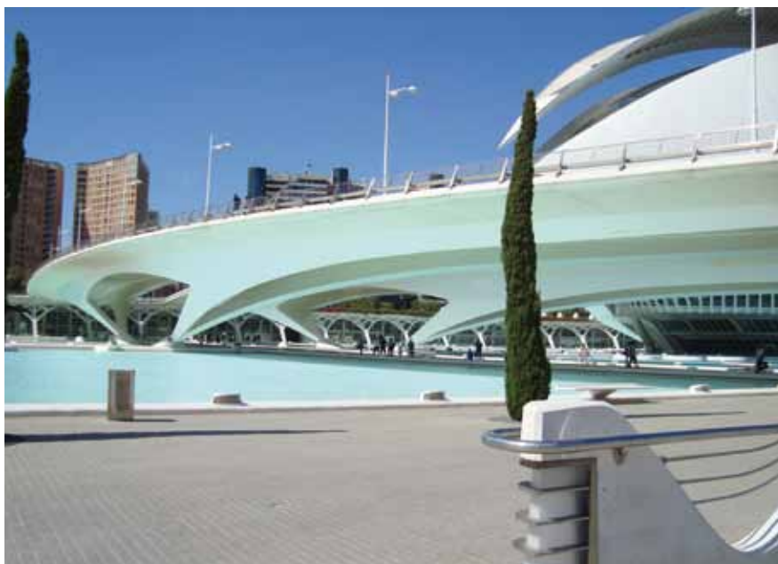
Figura 9. Puente de Monteolivete. Tramo Calatrava. Foto V. Yepes.
