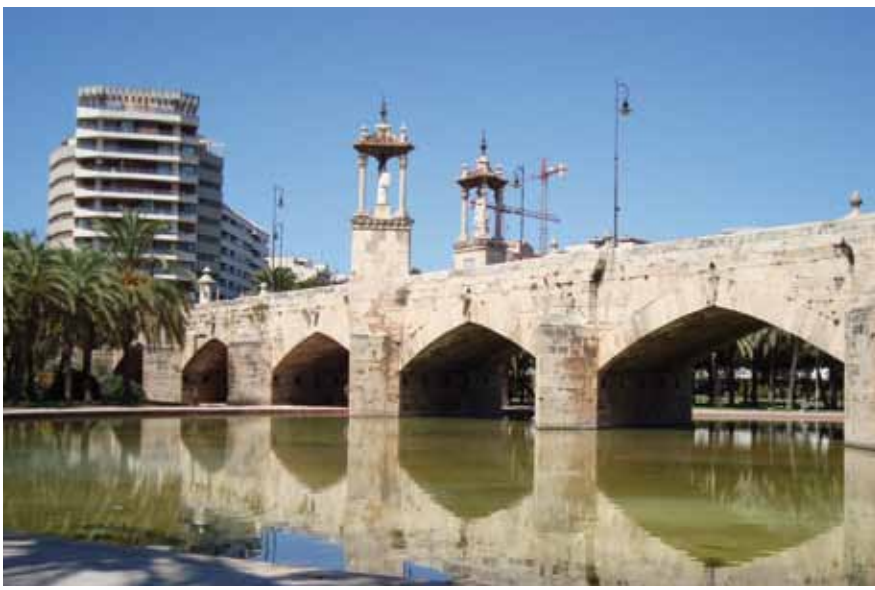
Fig. 8. Puente del Mar. Foto V. Yepes.
