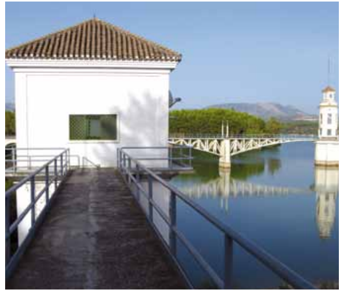
Figura 14. Presa de Cubillas.
