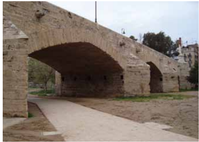
Fig. 6. Puente de la Trinidad. Foto V. Yepes
