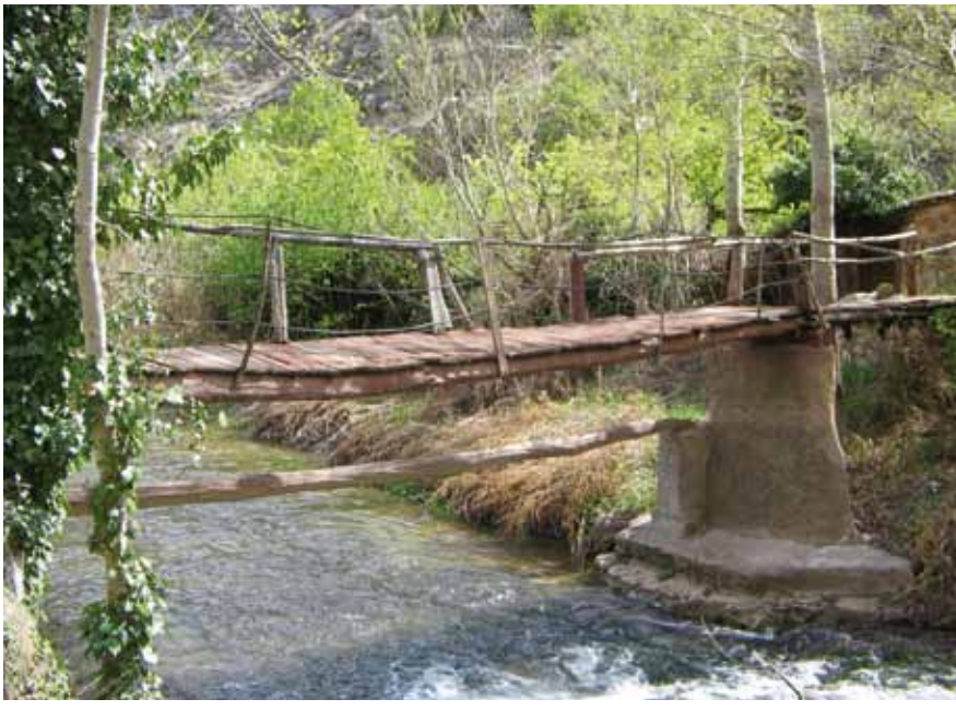
Fig. 2. Puente de madera. Foto V. Yepes.
