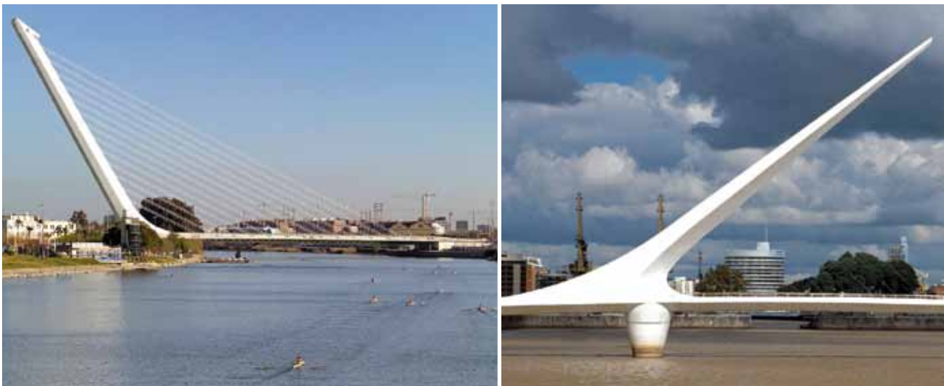
El "empalmo", como dicen en Sevilla, el pilono inclinado de El Alamillo de Santiago Calatrava, además de un icono fálico, es un hito en la construcción de puentes. Tuvo una influencia importantísima en la construcción y una repercusión mediática excepcional. Es de las primeras obras que mostraba que una propuesta formal caprichosa puede ser construida. Más sutil en su forma y en su concepto, pero manteniendo su misma intención escultórica, el puente de la Mujer en Buenos Aires, también de Calatrava, es un puente giratorio que simboliza la unión de una pareja bailando tango. Muy sexy.
