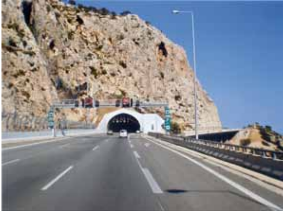
Fig.7. Embocadura de túnel en Grecia, acabada.
