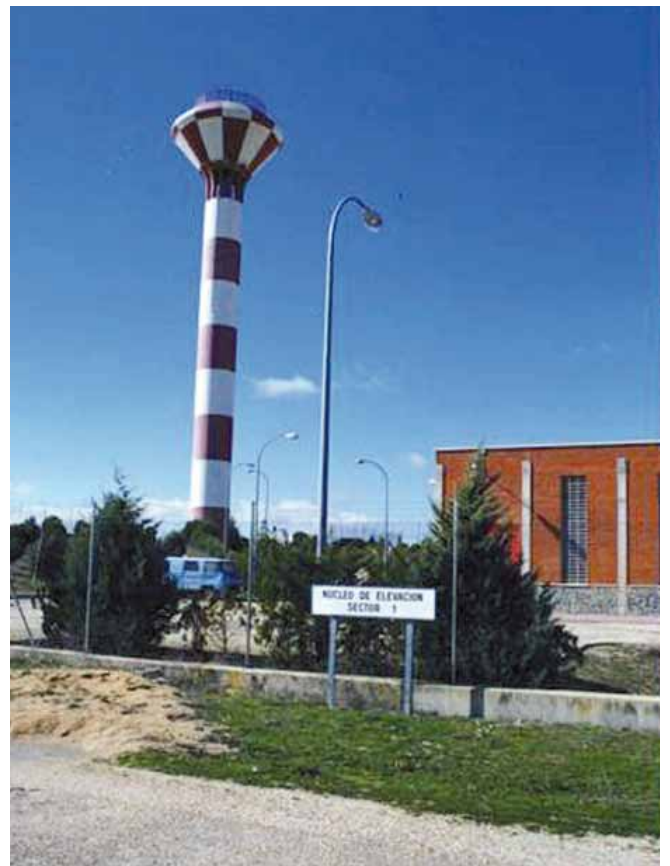
Figura 16. Depósito de agua en la zona regable de La Armuña (Salamanca).
