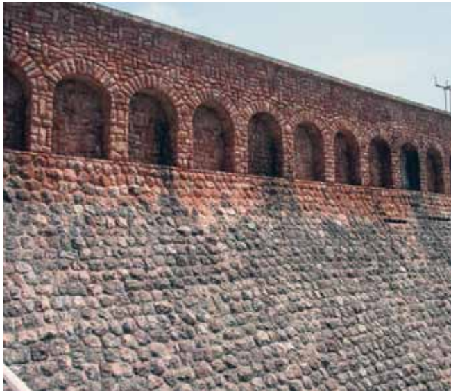
Figura 13. Presa de Bolarque.
