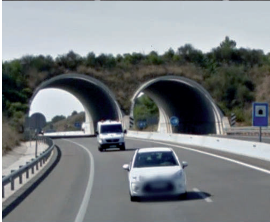
Autovía A-7. Paralelismo con la AP-7. Tarragona
