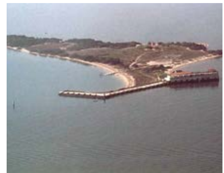
Vista de San José desde San Fernando
