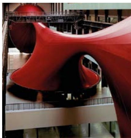
Anish Kapoor, Cecil Balmond, Marsyas , 2003. Una membrana de PVC roja y tres tubos rígidos de acero definen una superficie en tensión concebida mediante técnicas digitales de form-finding.
