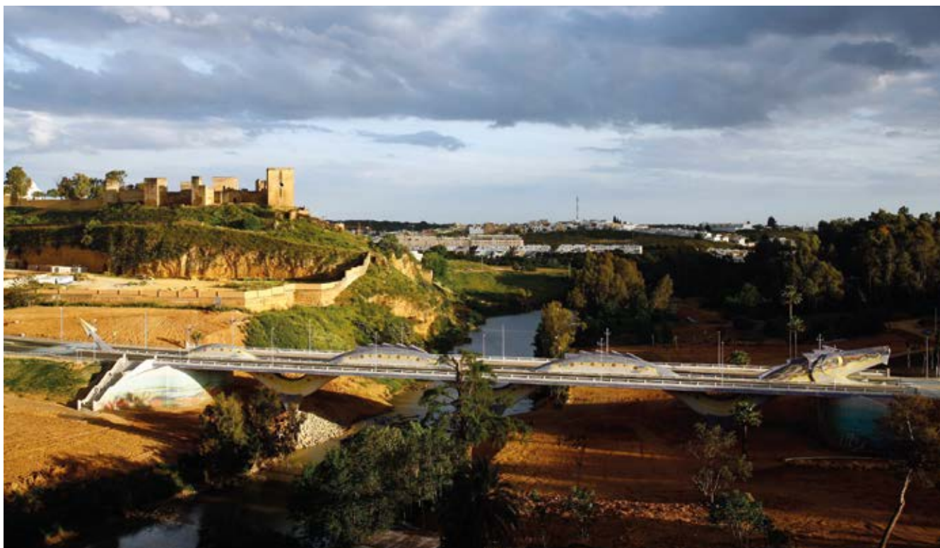
El puente del dragón en Alcalá de Guadaíra
