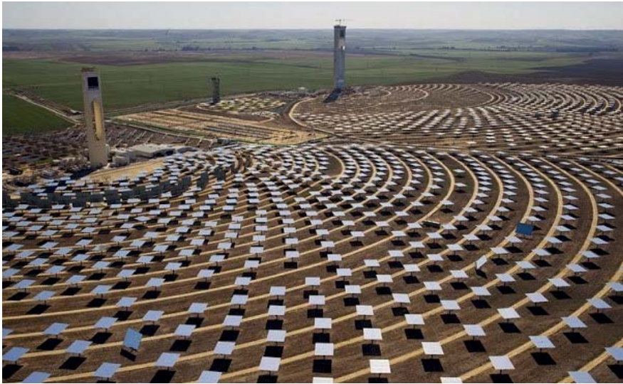
Foto 10. Centrales solares PS 10 y PS 20 en Sanlúcar la Mayor (FRANCISCO BUENO)
