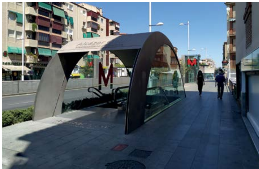
Entrada del metro ligero de Granada
