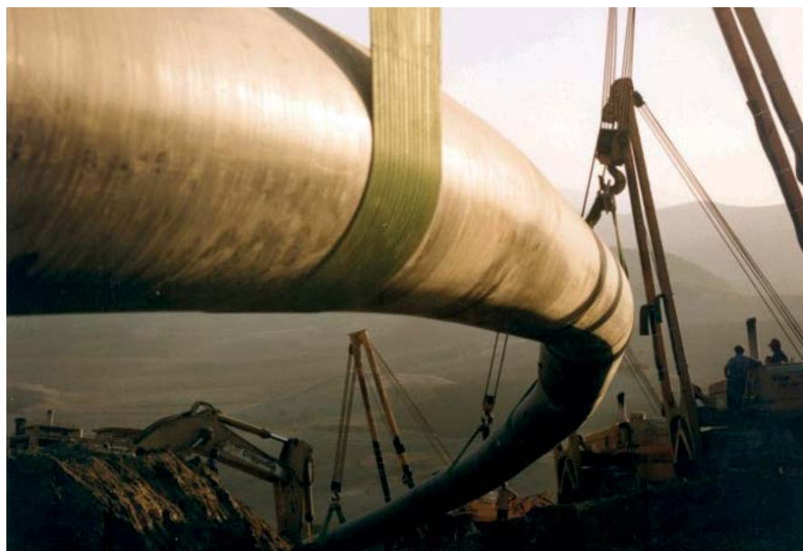
Foto 2. Construcción de gasoducto (ENAGÁS)
