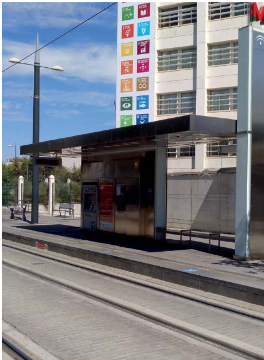
Marquesina del metro ligero de Granada
