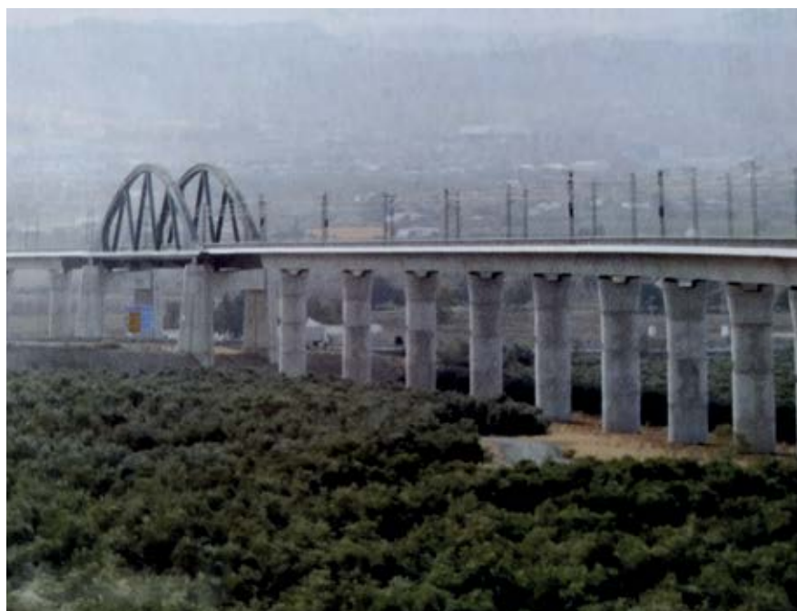
Viaducto del AVE Antequera-Granada. Paso sobre la Vega de Antequera
