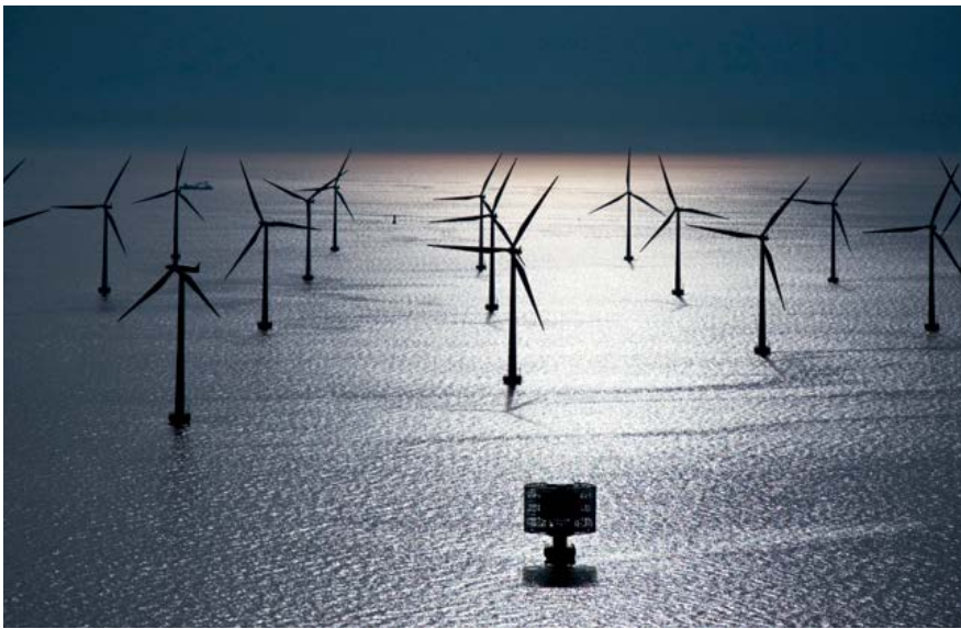
Foto 11. Parque eólico marino
