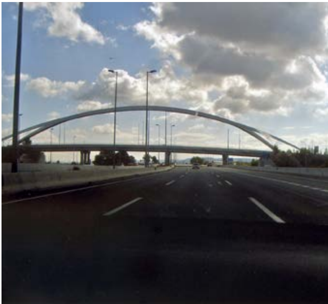
Autovía de La Coruña - Un gran arco innecesario. Su objetivo: la funcionalidad visual
