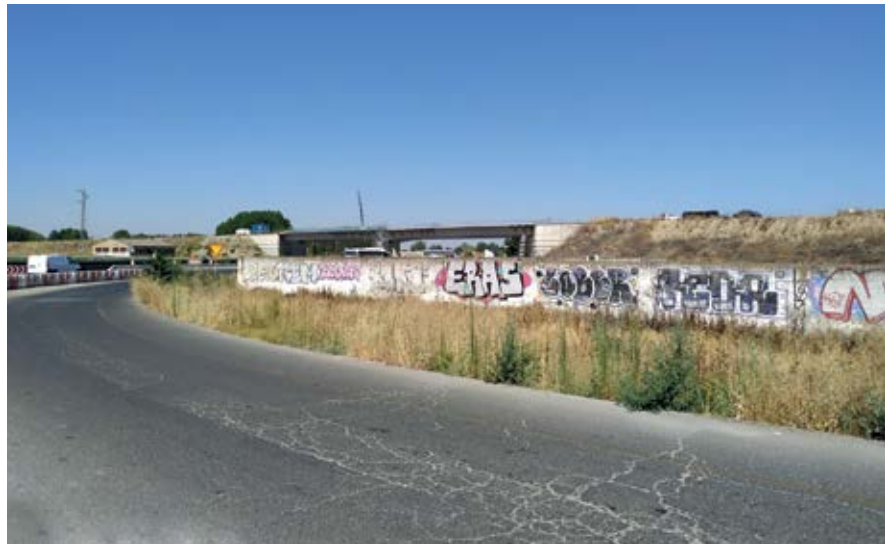
Terraplenes de la A-44 sobre la Vega de Granada
