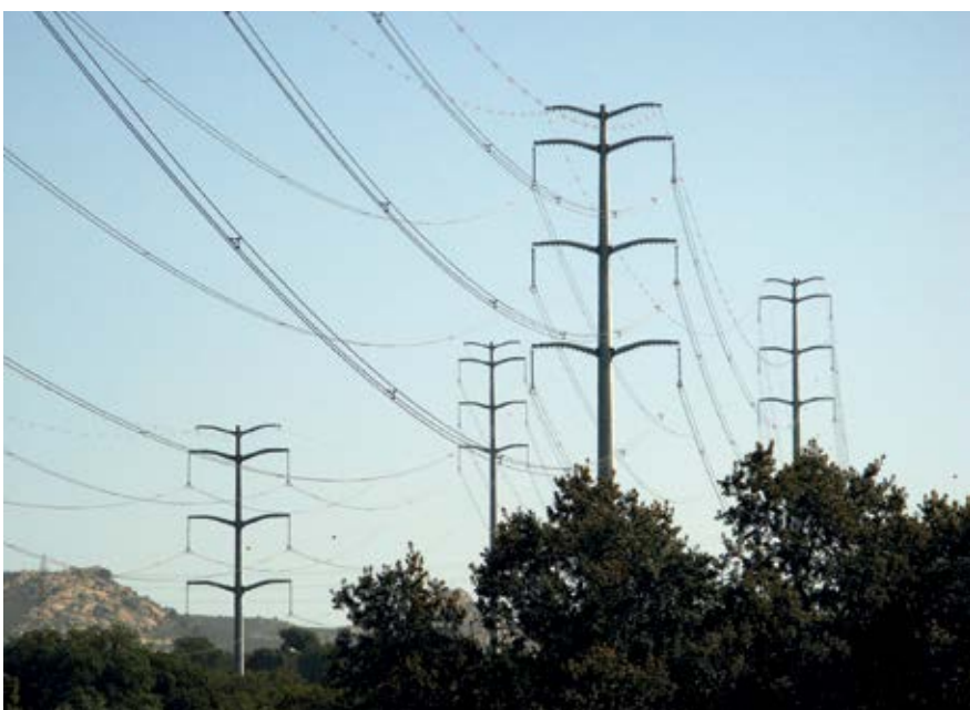
Foto 23. Postes "diferentes" en línea de alta tensión (FRANCISCO BUENO)
