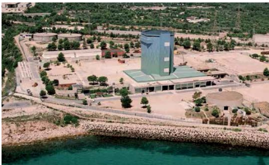
Foto 19. Central nuclear de Zorita de los Canes (Guadalajara) tras las primeras fases de desmantelamiento (ENRESA)
